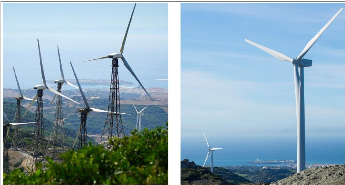
Imagen 1 Parque eólico El Cabrito, España, el antes y el después de su repotenciación.
