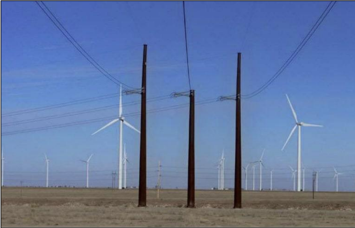
Imagen 8 Palas eólicas reutilizadas para postes de electricidad Fuente: CDT, 2022.
