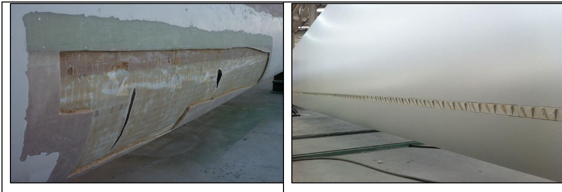
Imagen 2 Ejemplo de estructura reconstruida Fuente: ReWind.
